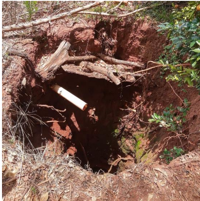
Figura 121: Fossa rudimentar/sumidouro a céu aberto, no Assentamento Rural Sebastião Rosa da Paz.
