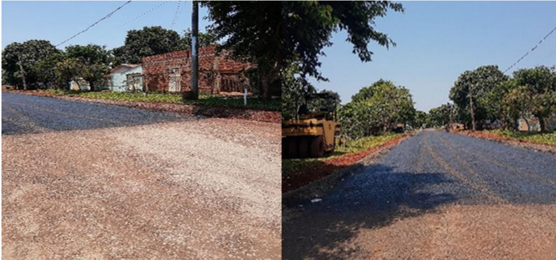
Figura 47: Ponto 8 de verificação da drenagem – DRE 08 (atualmente pavimentado).
