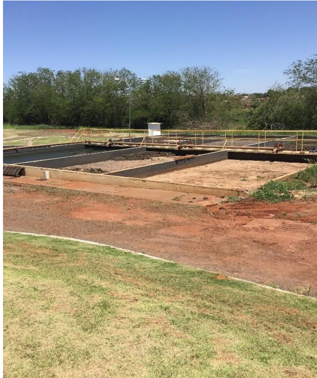
Figura 32: Leitos de secagem.
