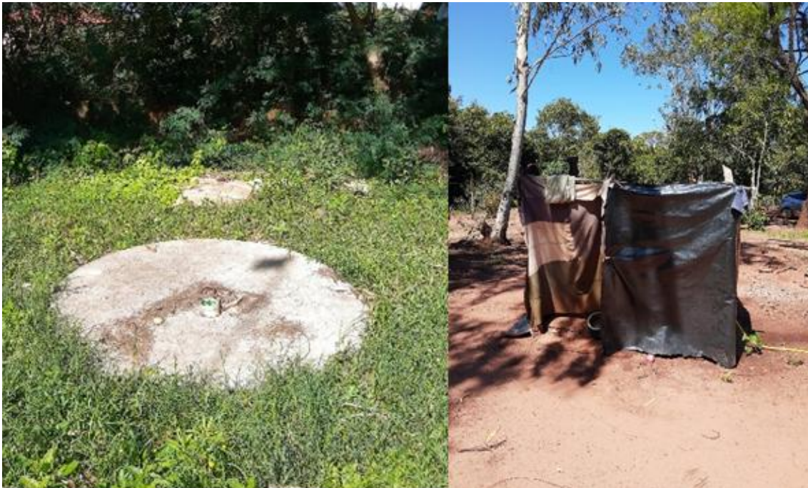
Figura 157: Fossa séptica rudimentar e banheiro externo à céu aberto na Aldeia indígena Amambai.
