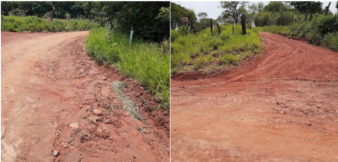
Figura 48: Ponto 9 de verificação da drenagem – DRE 09 (em estrada vicinal).
