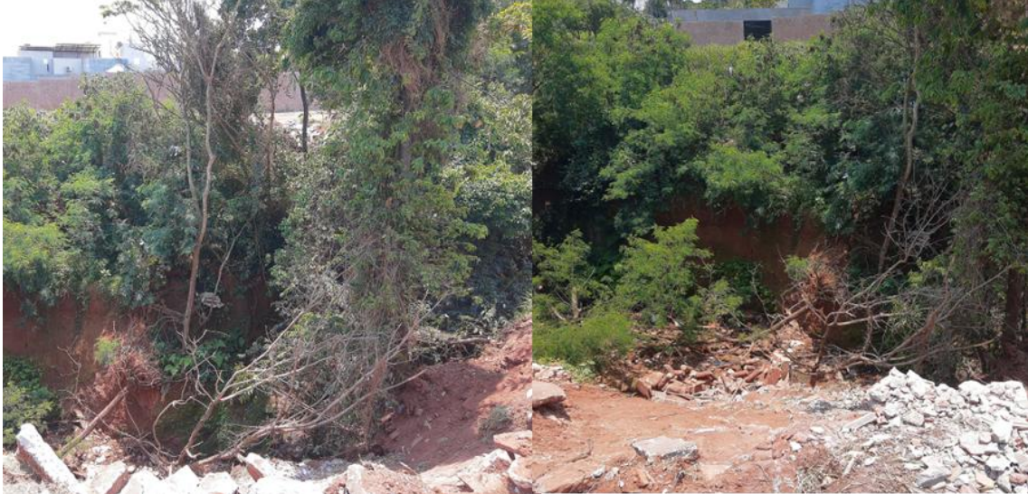
Figura 61: Ponto 21 de verificação da drenagem – DRE 21.
