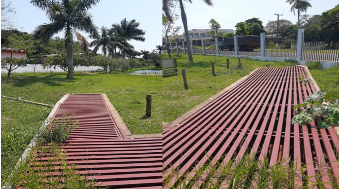
Figura 41: Ponto 2 de verificação da drenagem – DRE 02.
