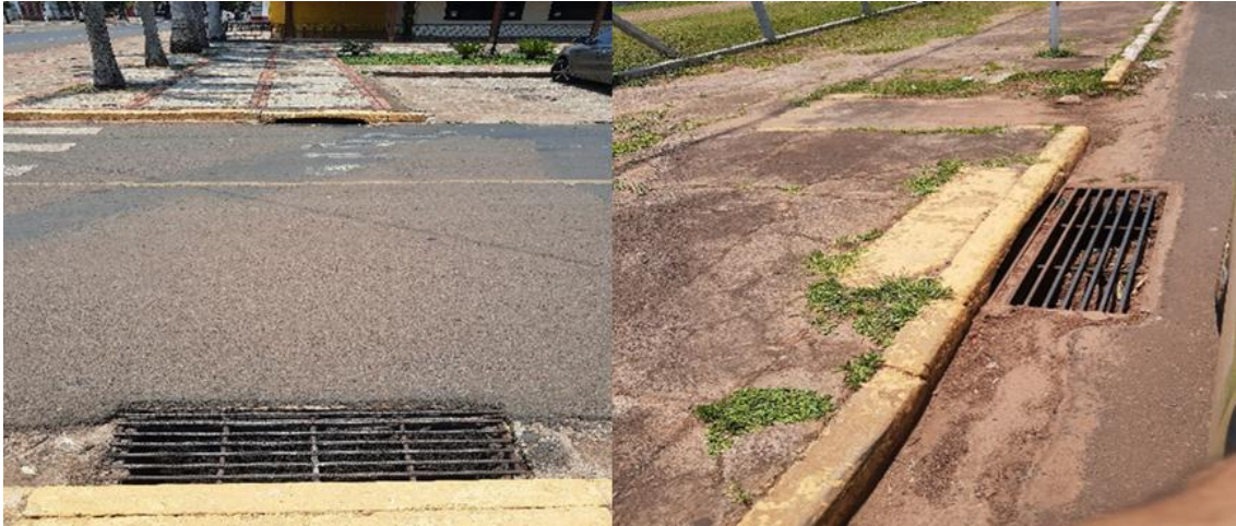
Figura 42: Ponto 3 de verificação da drenagem – DRE 03.
