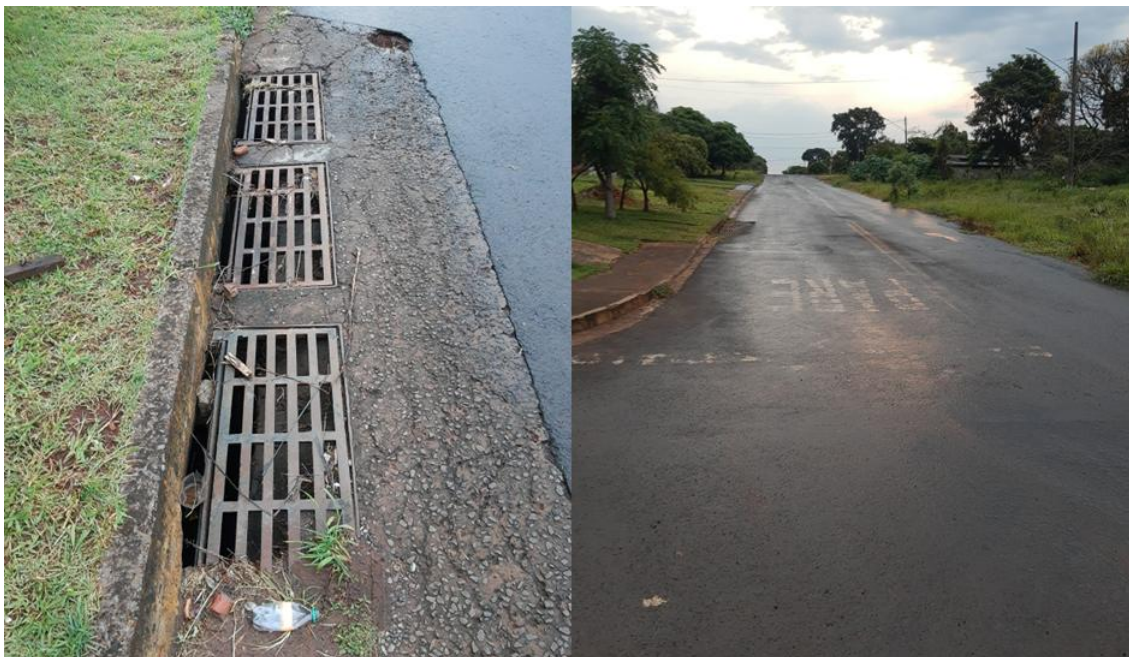
Figura 53: Ponto 14 de verificação da drenagem – DRE 14.
