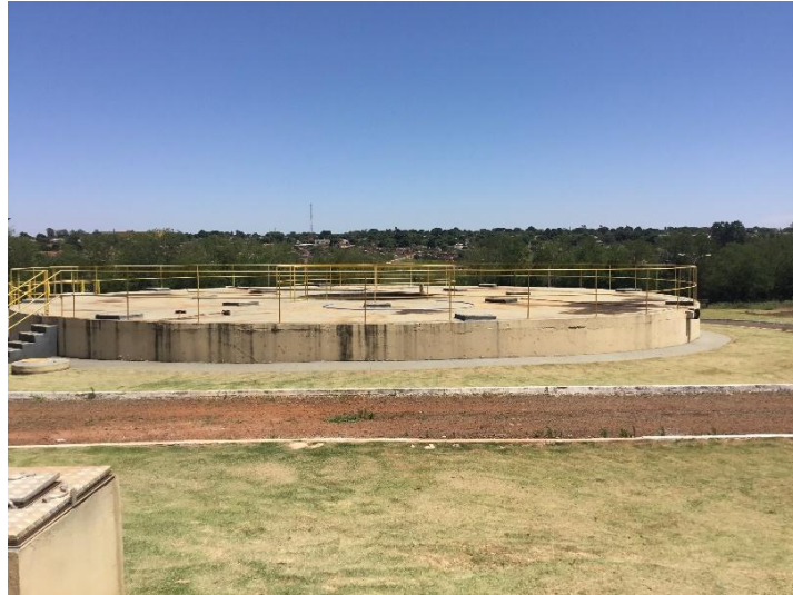
Figura 30: Reator Anaeróbio.
