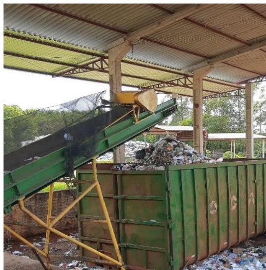
Figura 84: Contêiner para coleta dos rejeitos resultantes da triagem de resíduos recicláveis.
