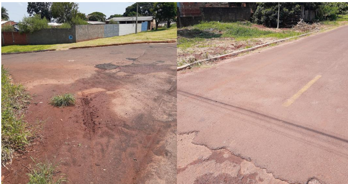
Figura 50: Ponto 11 de verificação da drenagem – DRE 11.
