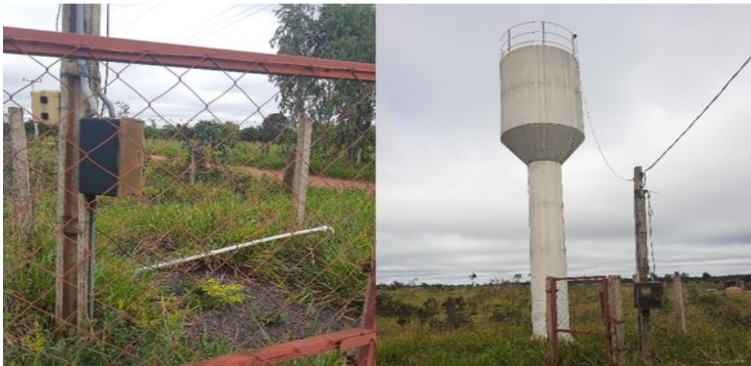
Figura 130: Poço e reservatório da associação de moradores 04, no assentamento Querência.
