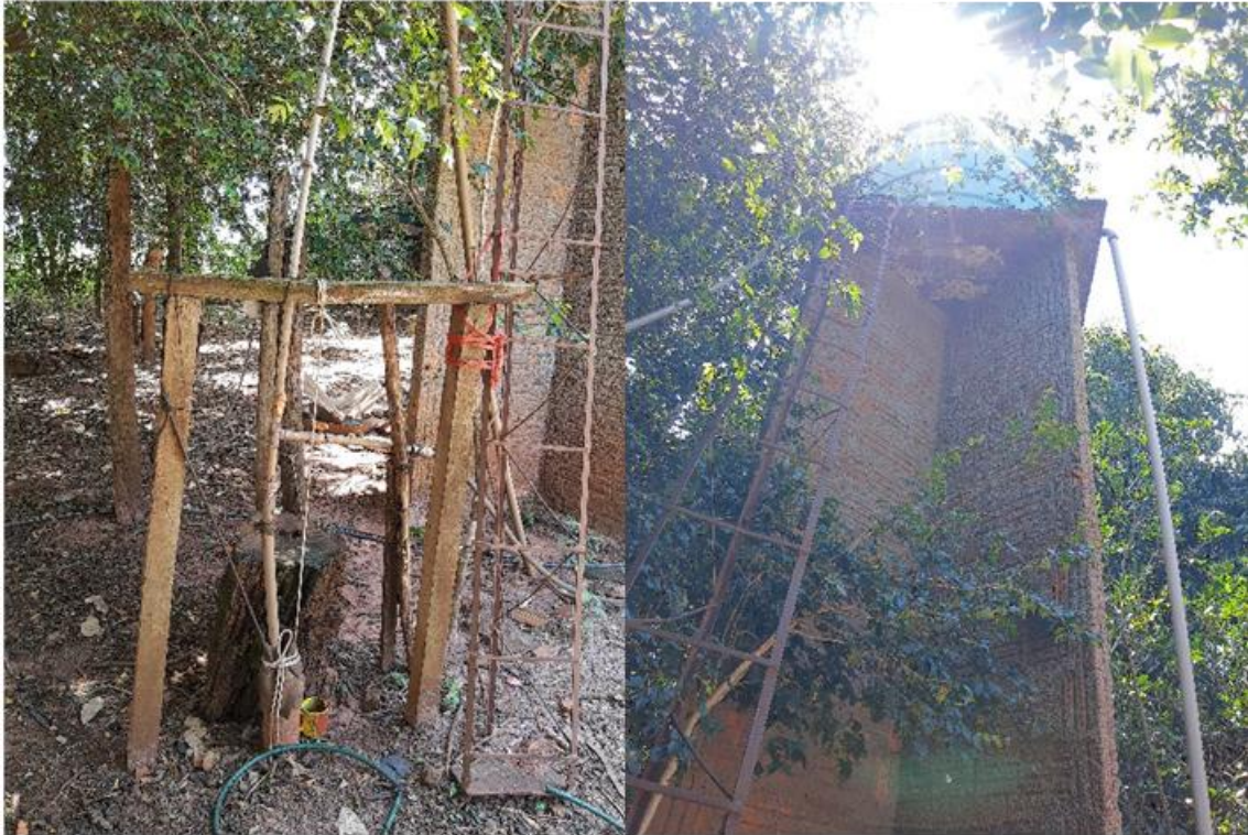
Figura 119: Poço artesiano particular e reservatório de 5.000 litros, no Assentamento Rural Sebastião Rosa da Paz.
