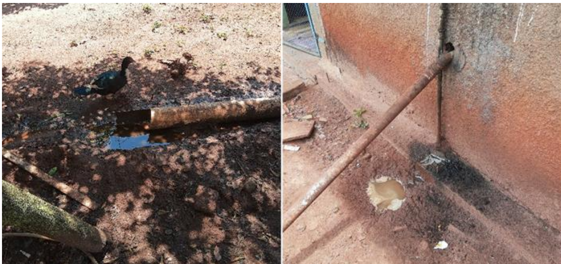
Figura 122: Efluentes domésticos despejados diretamente sobre o solo, no Assentamento Rural Sebastião Rosa da Paz.
