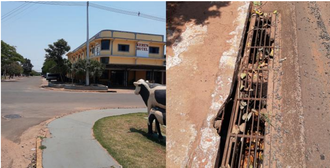
Figura 62: Ponto 22 de verificação da drenagem – DRE 22.
