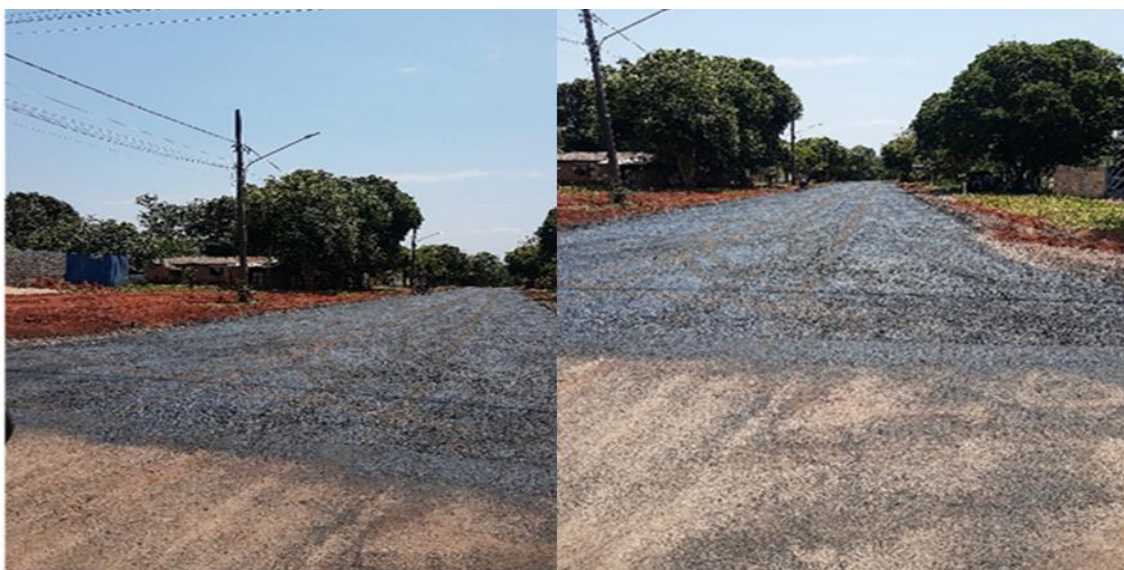
Figura 46: Ponto 7 de verificação da drenagem – DRE 07 (atualmente pavimentado).
