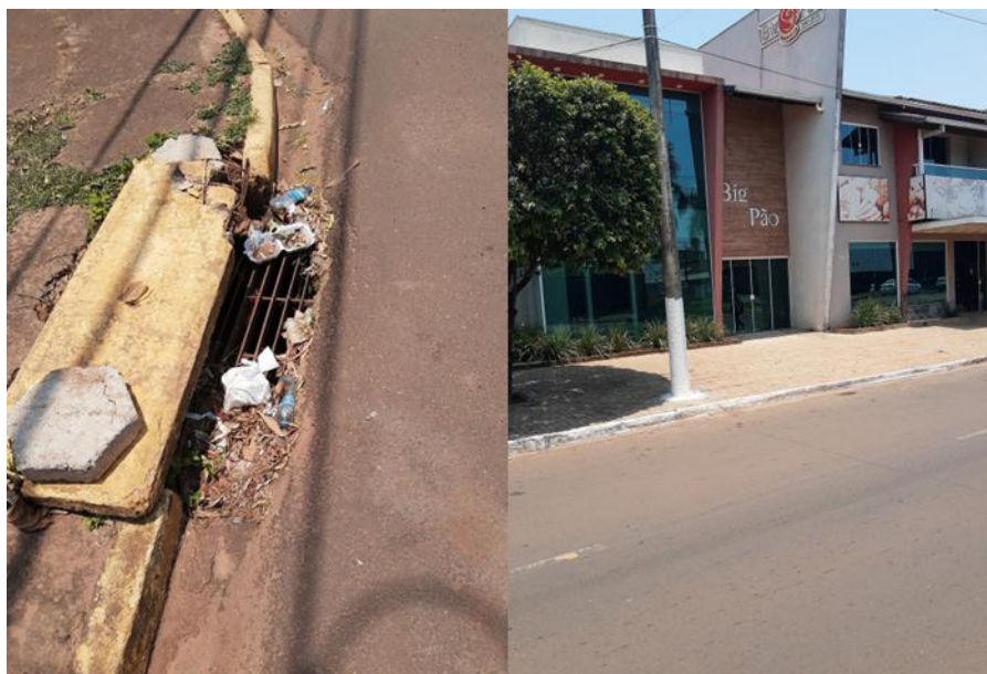
Figura 63: Ponto 23 de verificação da drenagem – DRE 23.
