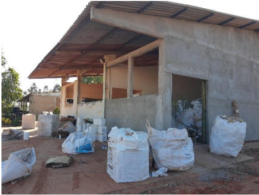
Figura 95: Área externa do galpão de armazenamento de embalagens vazias de agrotóxicos, gerenciado pela Asfron.
