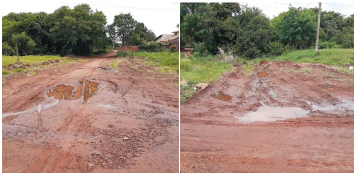
Figura 64: Ponto 24 de verificação da drenagem – DRE 24.
