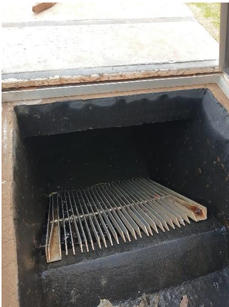
Figura 28: Gradeamento.
