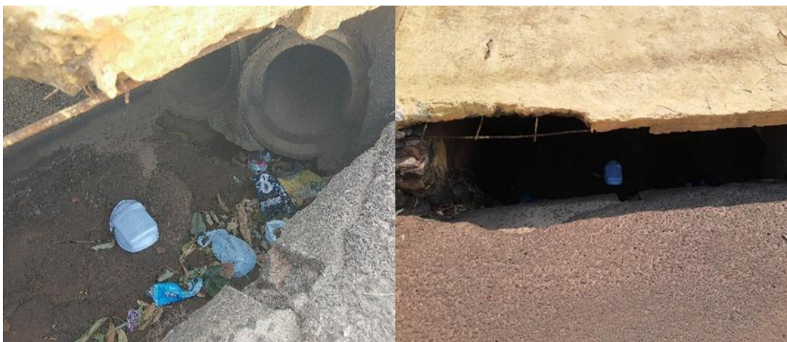
Figura 40: Ponto 1 de verificação da drenagem – DRE 01.
