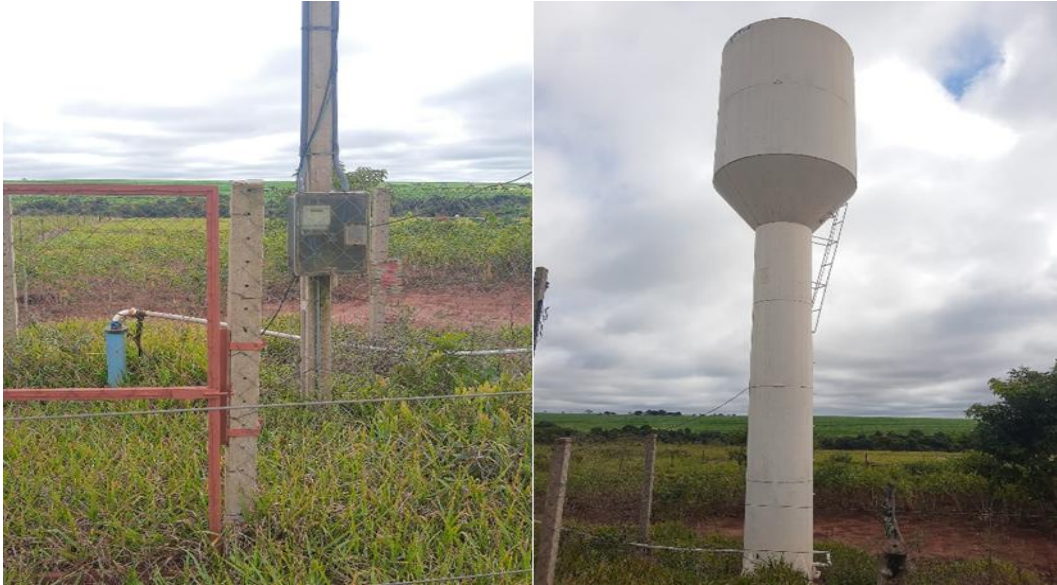
Figura 133: Poço e reservatório da associação de moradores 07, no assentamento Querência.
