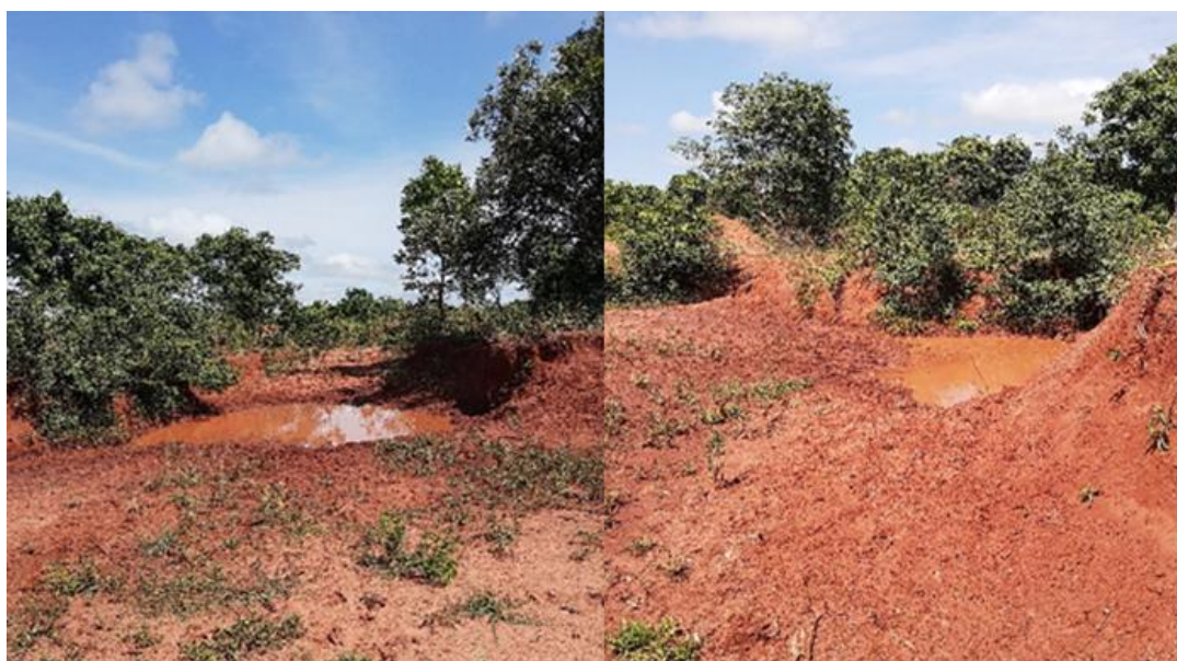
Figura 114: Processo erosivo e acesso de animais.
