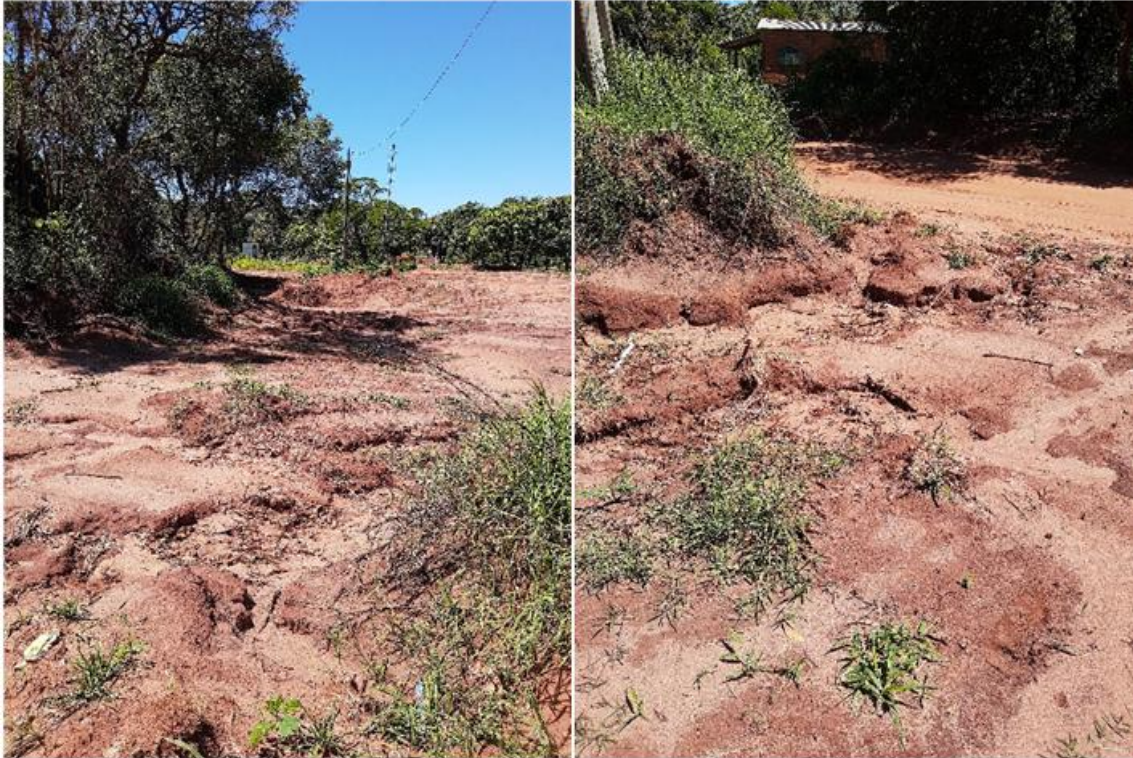
Figura 158: Local com início de processo erosivo, na Aldeia indígena Amambai.
