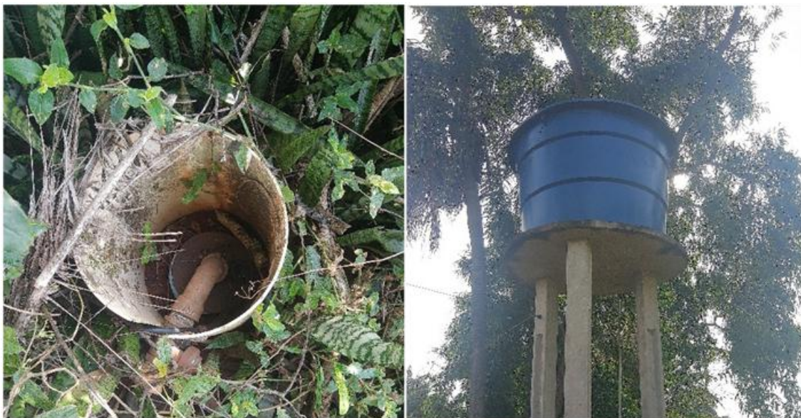
Figura 109: Poço e reservatório 01 no Assentamento Rural Guanabara.
