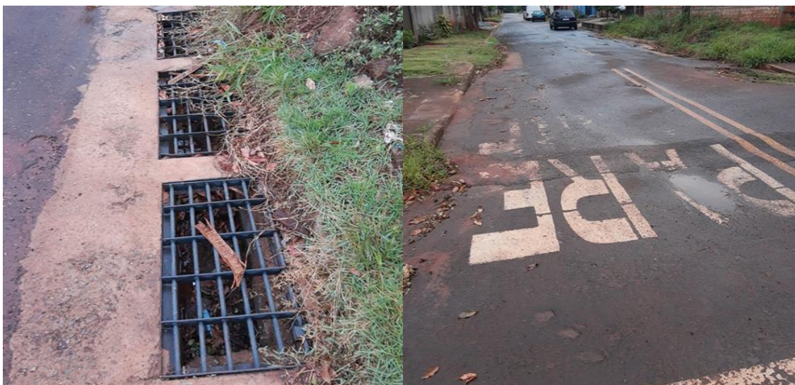
Figura 54: Ponto 15 de verificação da drenagem – DRE 15.
