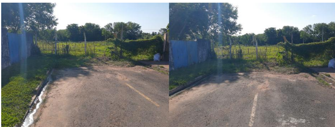
Figura 60: Ponto 20 de verificação da drenagem – DRE 20.
