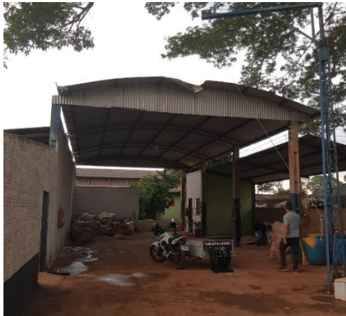
Figura 76: Galpão do PEV da Coopercicla.
