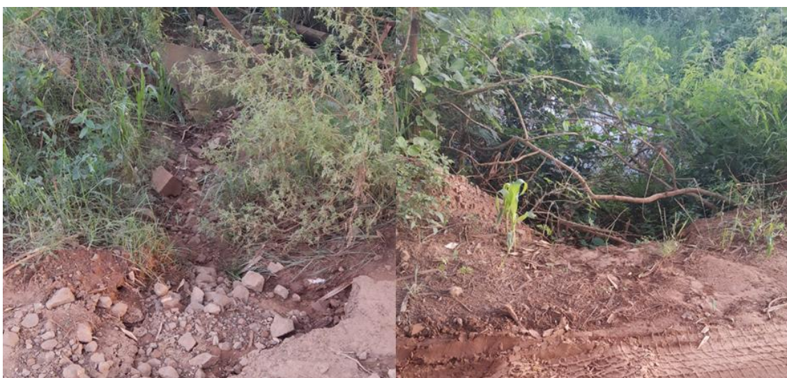
Figura 58: Ponto 18 de verificação da drenagem – DRE 18.
