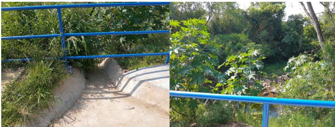
Figura 57: Ponto 17 de verificação da drenagem – DRE 17.
