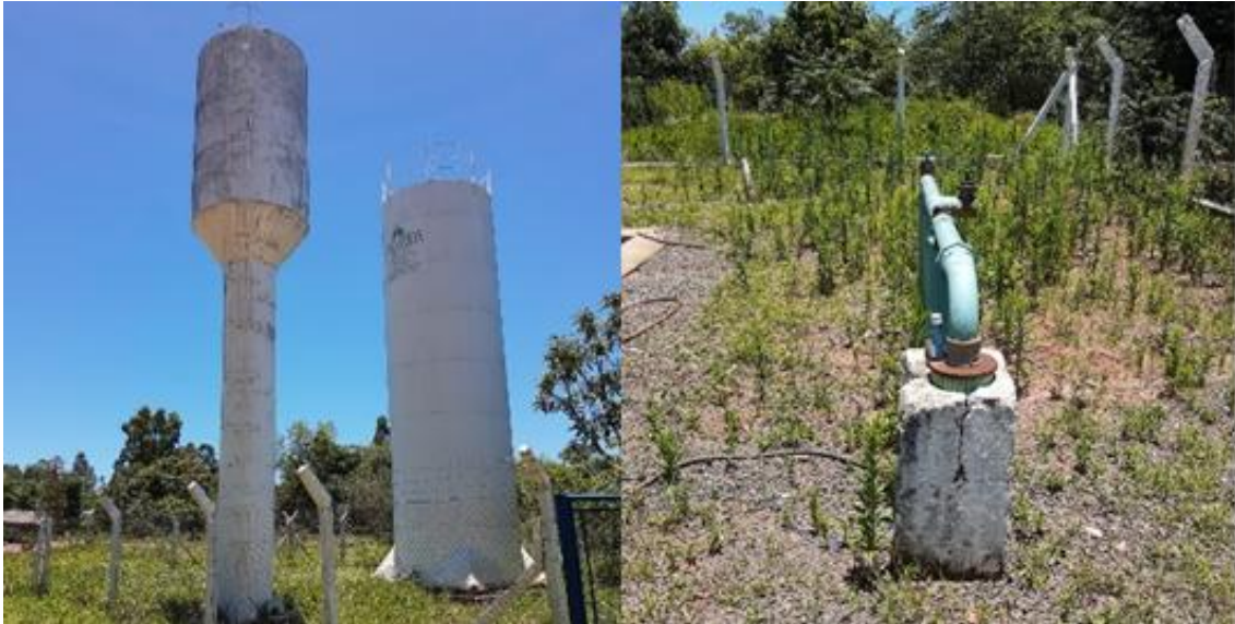
Figura 147: Reservatórios e poço artesiano PT 02.
