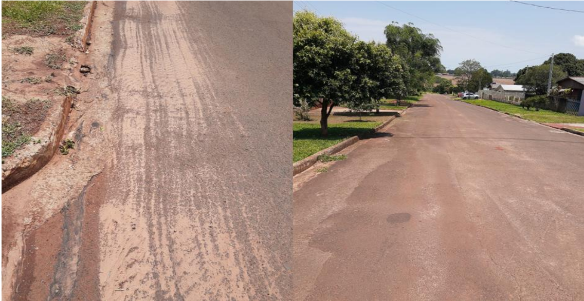
Figura 51: Ponto 12 de verificação da drenagem – DRE 12.
