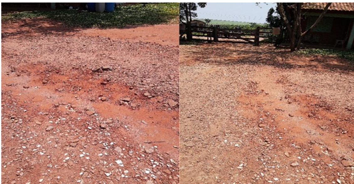
Figura 44: Ponto 5 de verificação da drenagem – DRE 05.
