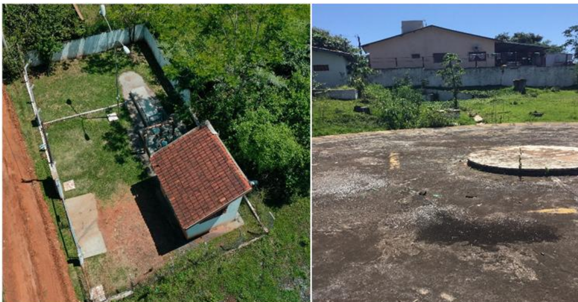
Figura 24: ETE Francisco Serejo Neto. Atualmente funciona como Estação Elevatória de Esgoto.
