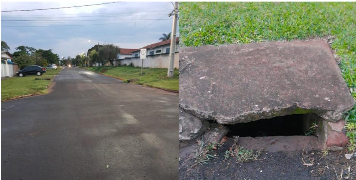
Figura 52: Ponto 13 de verificação da drenagem – DRE 13.
