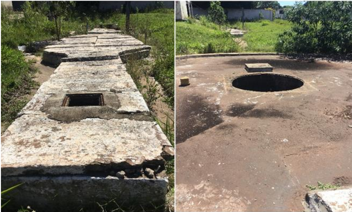
Figura 23: ETE Copacabana, atualmente desativada.
