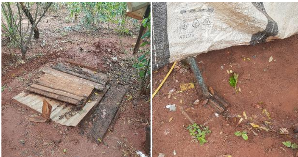
Figura 134: Fossa rudimentar e despejo de efluente da lavanderia diretamente sobre o solo, no assentamento Querência.
