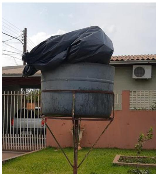
Figura 69: Acondicionamento dos resíduos convencionais em sacos plásticos dispostos em lixeira elevada.
