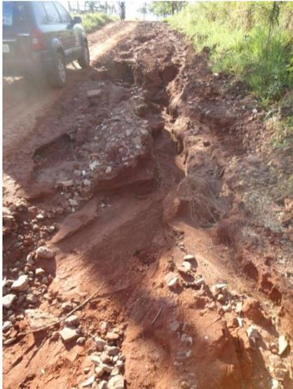
Figura 74: Estrada vicinal com erosão.
