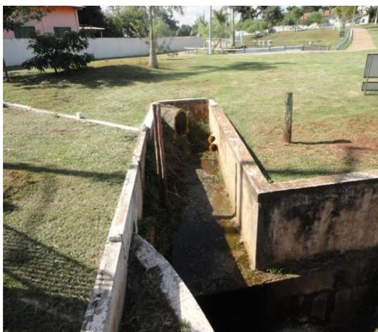
Figura 50: Dissipador de energia.
