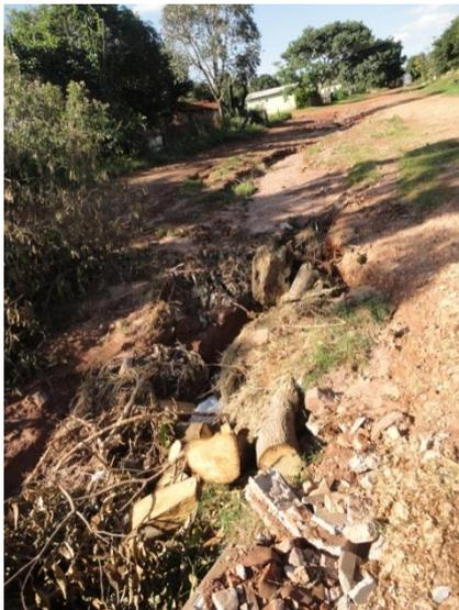
*Figura 70: Erosão preenchida com podas de árvores e entulho.*
