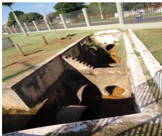
Figura 51: Dissipador de energia.
