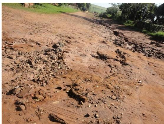
Figura 67: Erosão em sulcos no Ponto AM DRE 07.
