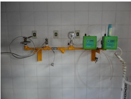
*Figura 13: Dosador de Cloro Líquido gasoso.*
