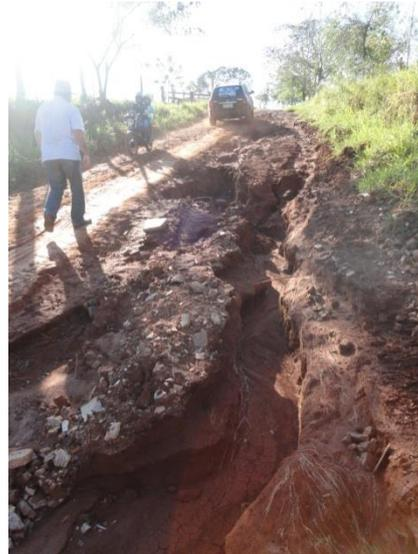
Figura 75: Estrada vicinal com erosão do tipo ravina.
