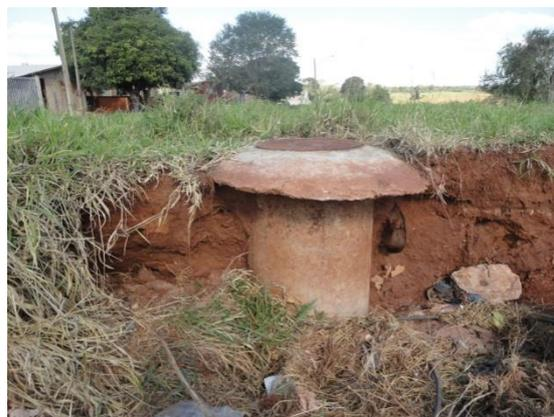
Figura 62: Poço de visita da rede de esgoto exposto.
