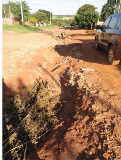
Figura 83: Erosão na Rua dos Mineiros preenchida com restos de podas de árvores.
