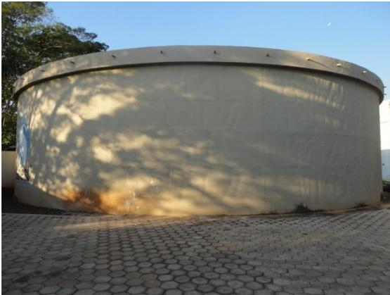
*Figura 9: Reservatório apoiado de 1.000 m³.*
